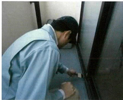
「外部（バルコニー）」調査の様子
