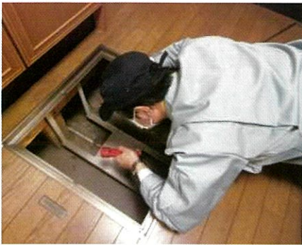
「土台・床組、基礎」調査の様子
