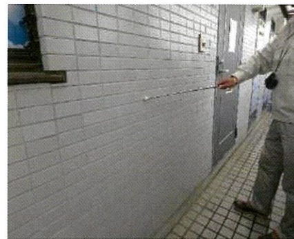
「外部（外壁）」調査の様子
